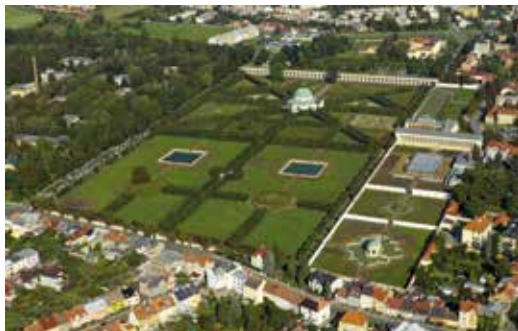
Letecký pohled na Květnou zahradu po dokončení obnovy. (Karban 2014)
