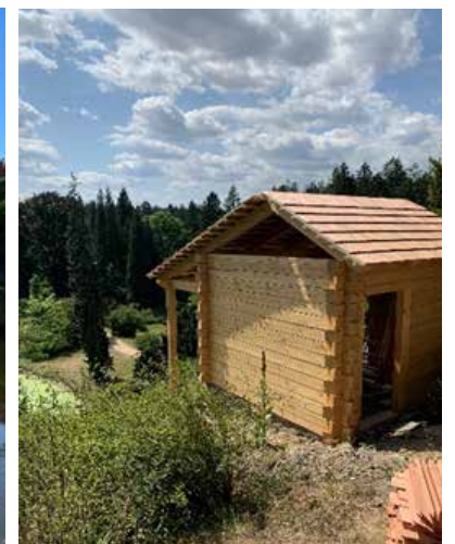
Oprava Alpského srubu (foto: Jiří Plichta)
